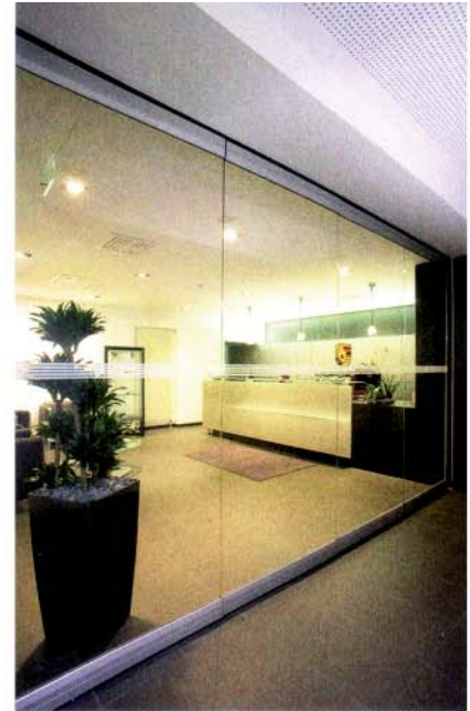
Glasschiebewand mit dezent verdecktem Beschlag. Während der Geschäftszeiten „verschwindet“ das System in der Wandöffnung im Bildhintergrund. Bild: Gez
